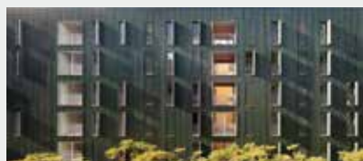
66 Edificio de 47 viviendas de protección oficial 47-unit social housing building Barcelona. Spain dataAE + Narch + Maira Arquitectes
