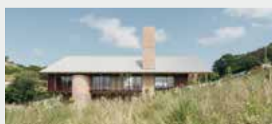
122 Casa Nahinuena Nahinuena House Góriz, Bizkaia. Spain BeAr Architects
