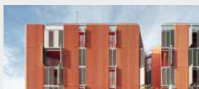
50 72 viviendas sociales en Marina del Prat Vermell 72 social housing units in Marina del Prat Vermell Barcelona. Spain Coll-Leclerc + MIAS Architects
